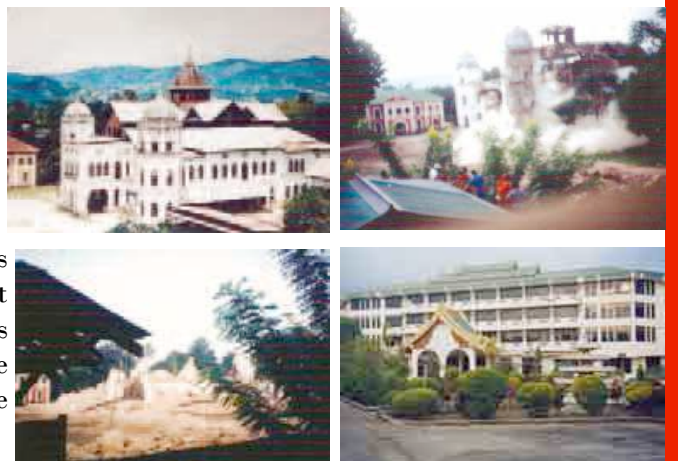
Le palais de Kengtung, bâti en 1903, a été détruit en 1991 sur ordre des autorités de Rangoon. A la place fut construit par le ministère du tourisme un hôtel moderne, le 'Kyaing Tong Hotel'.
